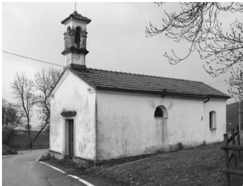
A San Gervasio sono state rifatte le porte per l'interessamento della frazione. A tutti il grazie della comunità.
