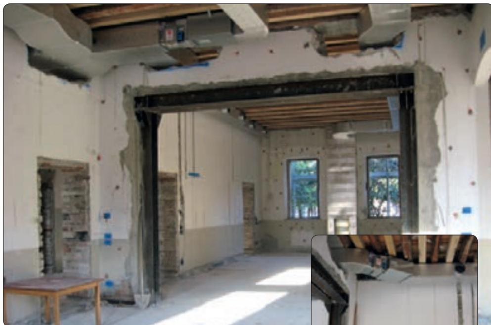
*Sopra:* Le due aule che danno sulla veranda sono state unite aprendo il muro divisorio, sostituito – per ragioni statiche – da una solida struttura in ferro (vedere anche foto a destra). In alto si vedono i canali di aerazione e per il riscaldamento. Saranno coperti da un controsoffitto che costituirà a sua volta l'elemento radiante del riscaldamento a soffitto, appunto.
