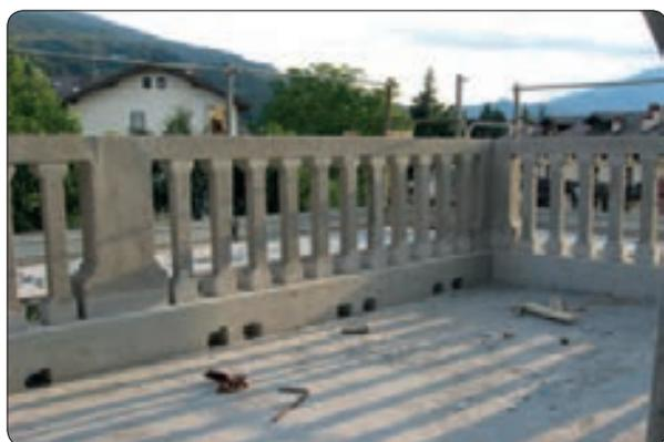
*Sopra:* La terrazza. L'elemento architettonico caratteristico dell'edificio viene mantenuto. Il parapetto in cemento e graniglia è stato portato all'altezza di norma, grazie al muretto in cemento su cui poggia ora. È restaurato recuperandolo integralmente.
