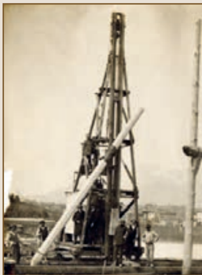
Cesana 1920, Giovanni sulla macchina battipalo durante la costruzione del ponte.
