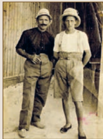
Hordio (Somalia) 1928, Giovanni (a sinistra con i baffi) presso una baracca di cantiere
